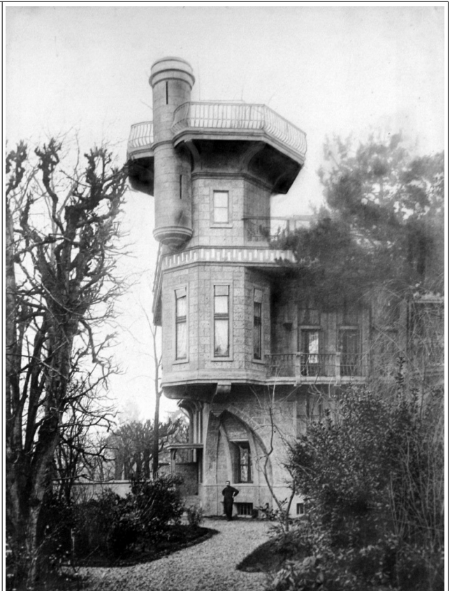
Photo : date et auteur inconnus, probablement à la fin de la construction
